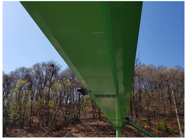
바닥판하면 및 거더 전경
